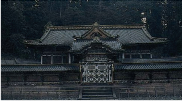
正面から見た唐門
